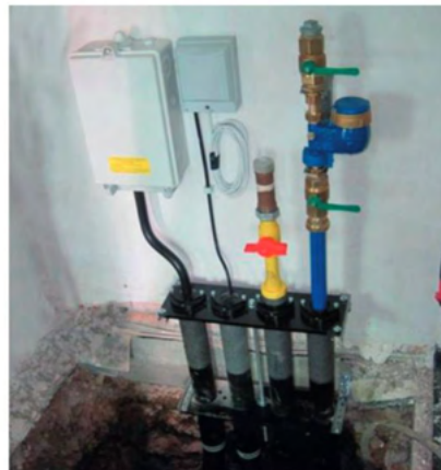
Mehrsparten-Hauseinführung für Gebäude ohne Keller Typ 4 pipes MSHE-BT
